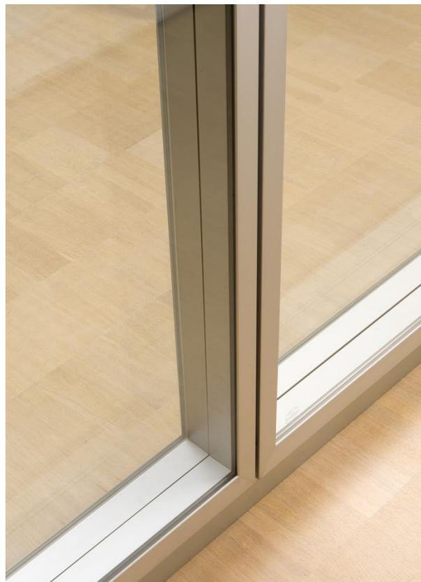
Die tragende Unterkonstruktion besteht aus boden- und deckenmontierten Profilen, die tragende Stahlpfosten halten. Die beidseitigen Verglasungselemente sind Einscheiben- oder Verbund-sicherheitsglasscheiben, die in Aluminiumrahmen sitzen und in die Pfostenkonstruktion eingesetzt sind. Die Wandstärke beträgt 100 mm bzw. 125 mm bei höheren Anforderungen an Schallschutz und/oder Statik.
