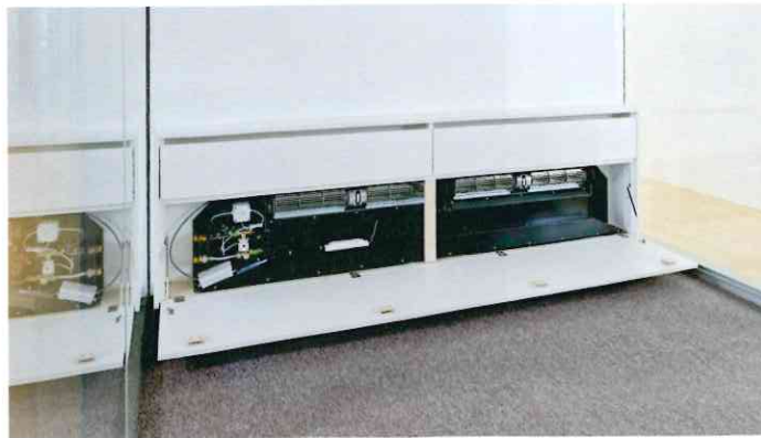
/ Für Behaglichkeit sorgt der in einem Sideboard integrierte Kühlkonvektor, der unabhängig von vorhandener Haustechnik als Plug-and-Play-Lösung eingesetzt wird.
