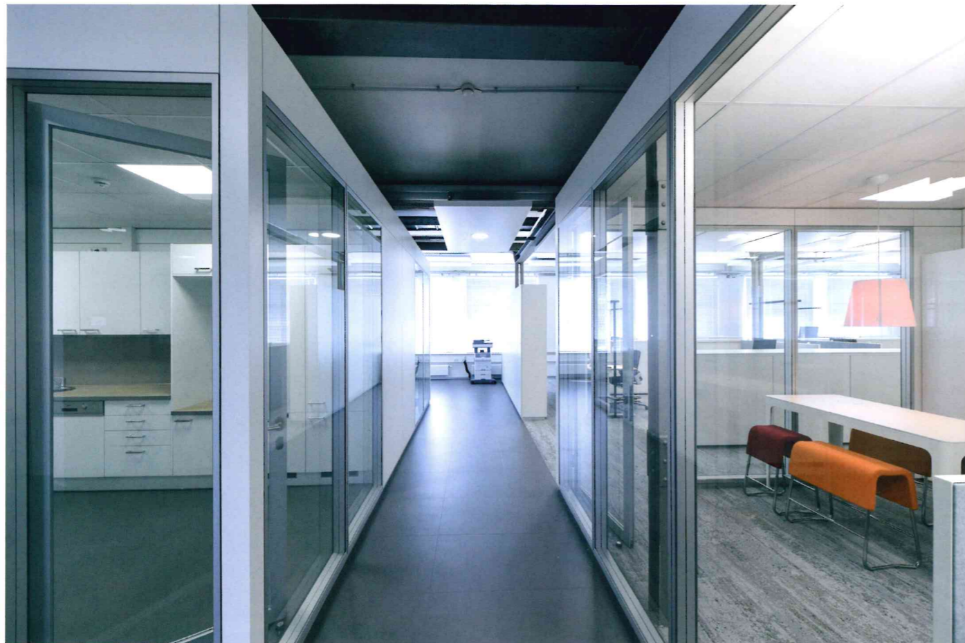
▲ Das hochschalldämmende System schirmt Lärm aus Teeküchen und Kopierräumen ab
