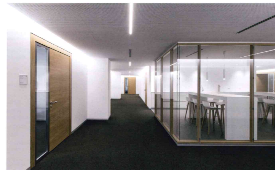
▲ Elegante Lösung: Die Ganzglasecken der offenen Küchen sind auf Gehrung geschnitten und mit unsichtbarer UV-Verklebung zusammengefügt
