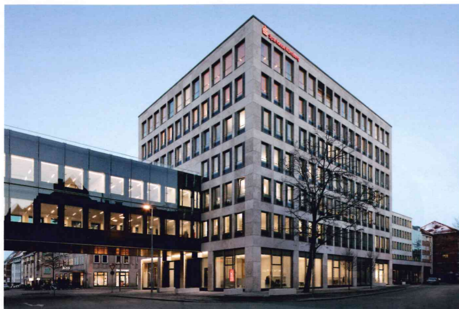
▲ Das Haus der Sparkasse Nürnberg in der Lorenzer Straße bietet nach gelungener Kernsanierung rund 220 Mitarbeitern verschiedener Abteilungen moderne, helle Arbeitsplätze
