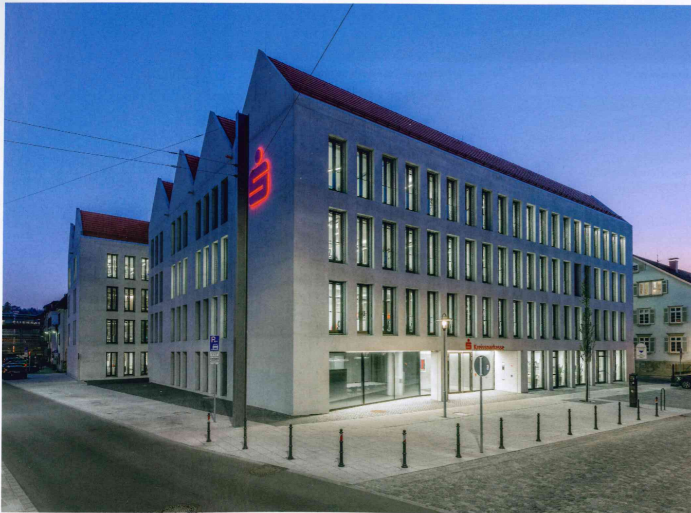
▲ Unter der Prämisse, eine Brücke zwischen der historischen Altstadt und moderner zeitgenössischer Architektur zu schlagen, entwarfen die Architekten einen monolithischen Betonbau mit aneinandergereihten Satteldächern als Reminiszenz an die Dachlandschaft der Innenstadt
