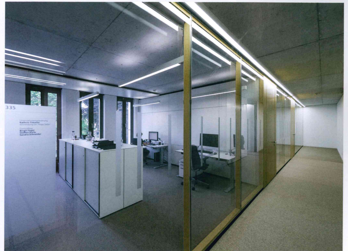
▲ Großen Wert legte die KSK auf hohen Schallschutz und gute Raumakustik. Durch hohe Schalldämmwerte und den Einsatz von Absorbern tragen die Systeme zu einer angenehmen Arbeitsumgebung bei
