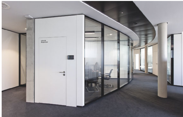
/ Der Gebäudekontur folgend: Raumhohe Thinktanks sorgen für den erforderlichen Schallschutz bei Meetings.
