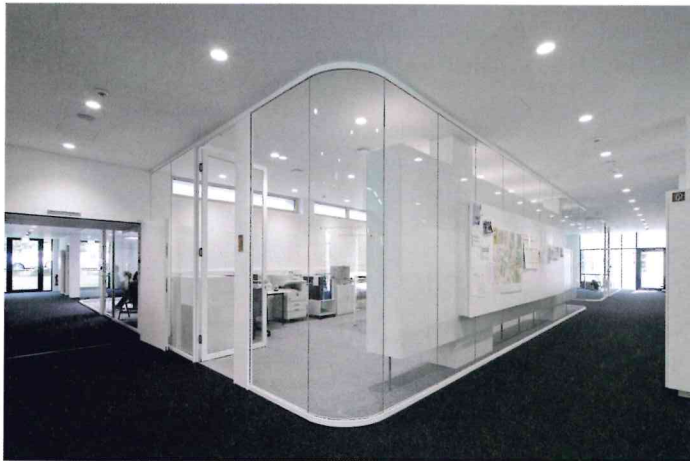
/ Maximale Transparenz: Durch die leichte Ganzglaskonstruktion erhalten auch innen liegende Besprechungsräume noch ausreichend Tageslicht.
