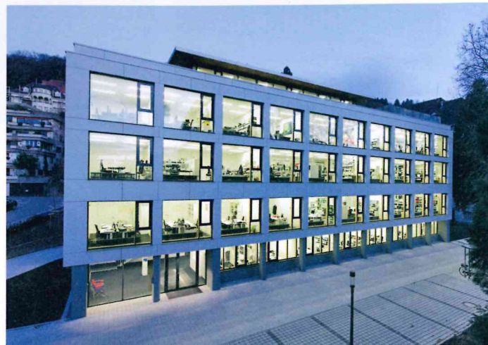
/ Große, neu geschaffene Fensteröffnungen belichten nach dem Umbau des ehemaligen Gesundheitsamtes nun die Räume des Freiburger Bauamtes.
