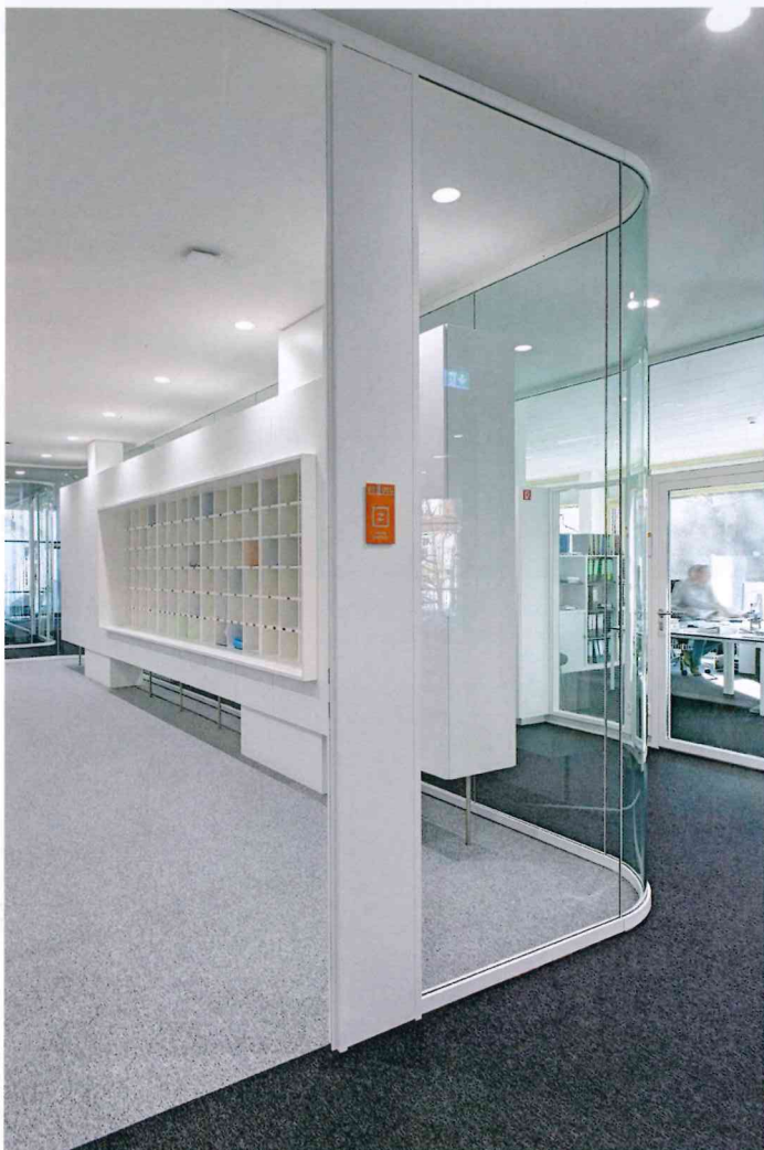
/ Doppelnutzung: Der individuell angefertigte Postfachschrank durchdringt die Glaswand und dient zum Flur hin als Infoboard für die Mitarbeiter.
