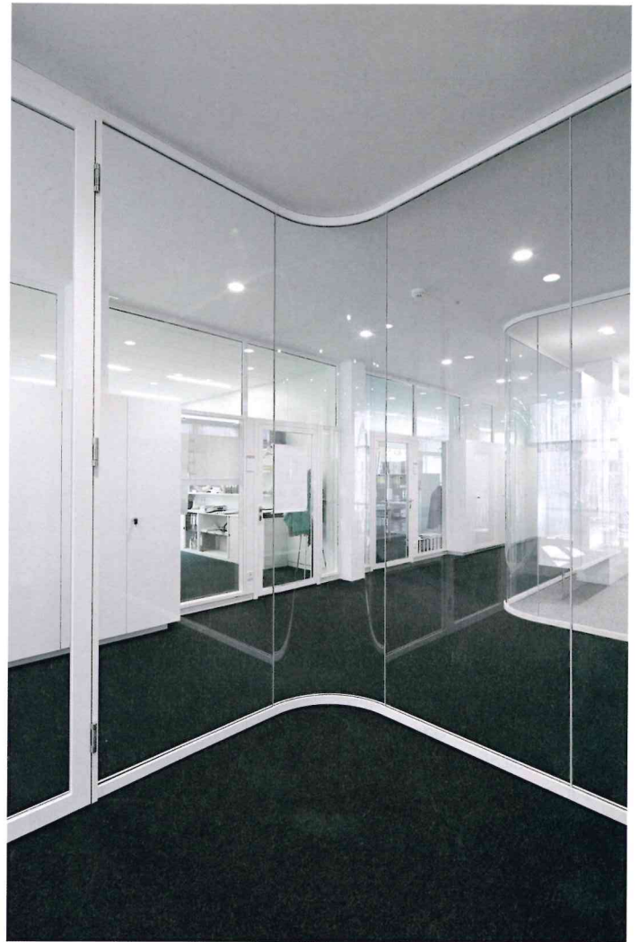
/ Sanfte Kurven: Im Radius von 500 mm gebogene ESG-Scheiben bilden die „Ecken“ der fast 3,40 m hohen Ganzglaskonstruktion.
