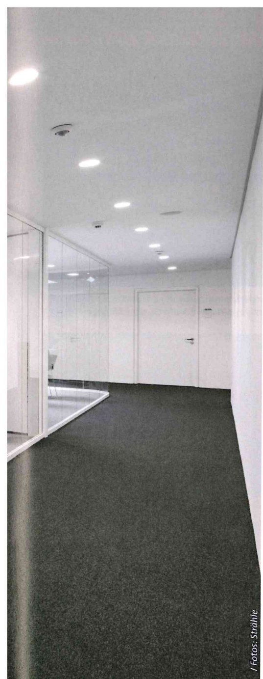
/ Offene, kommunikative und flexible Büro- und Besprechungsräume für 80 Beschäftigte zu schaffen, war die Maßgabe der Bauherren bei der Revitalisierung des ehemaligen Freiburger Gesundheitsamtes. Raumhohe Ganzglastrennwände des Waiblinger Herstellers Strähle sorgen nach dem Umbau für maximale Transparenz.
