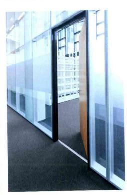
räume folgt dem Achsraster von 1,35 m mit dem 2-Achs-Büro als kleinster Einheit. Als Bürozwischenwand ist System 2000 in der Ausstattung mit weißer Melaminharzoberfläche eingesetzt. Das System 2000 gewährleistet einen Schallschutzwert von Rw,P 49 dB zwischen den Büroräumen, System 2300 einen Wert von Rw,P 47 dB zum Flur bzw. Atrium hin. Um in den Konferenzräumen einen Schalldämmwert von Rw,P 51 dB zu erreichen, kam die Systemvariante 2500 mit einer Wanddicke von 125 mm zum Einsatz
