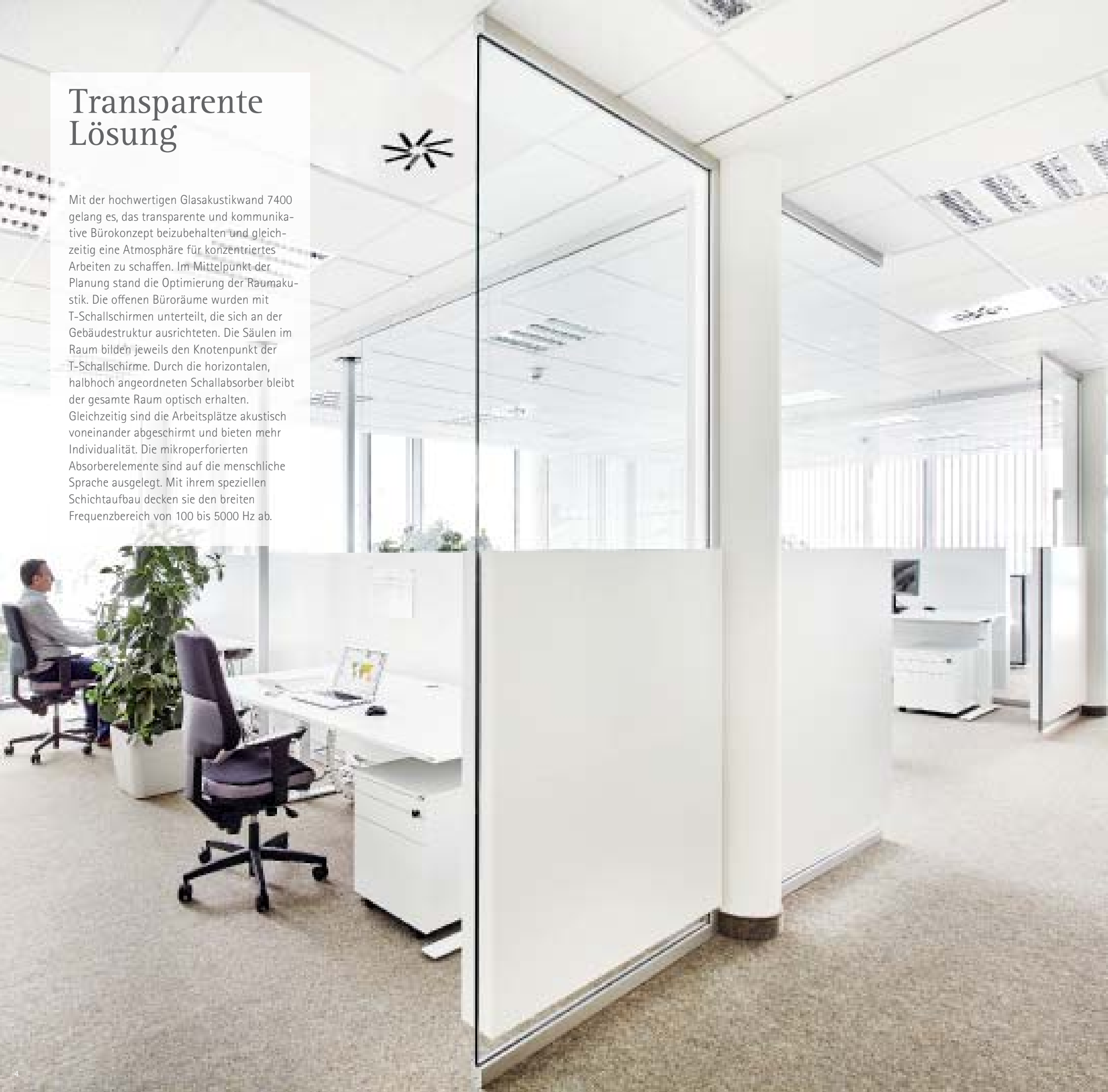
Zonierung der Bürofläche durch T-Schallschirme gebildet aus der Strähle Glasakustikwand 7400
