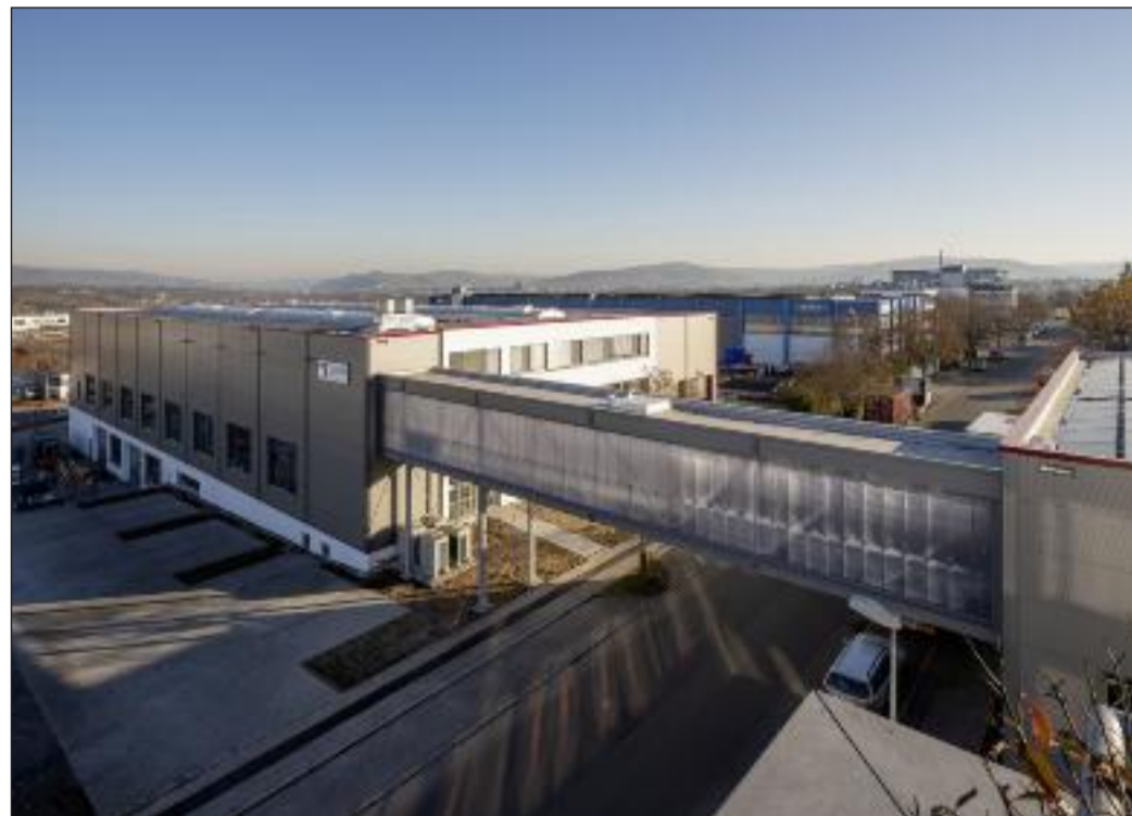
Die Brücke über die Straße ist das Herzstück des Gebäudekomplexes.
